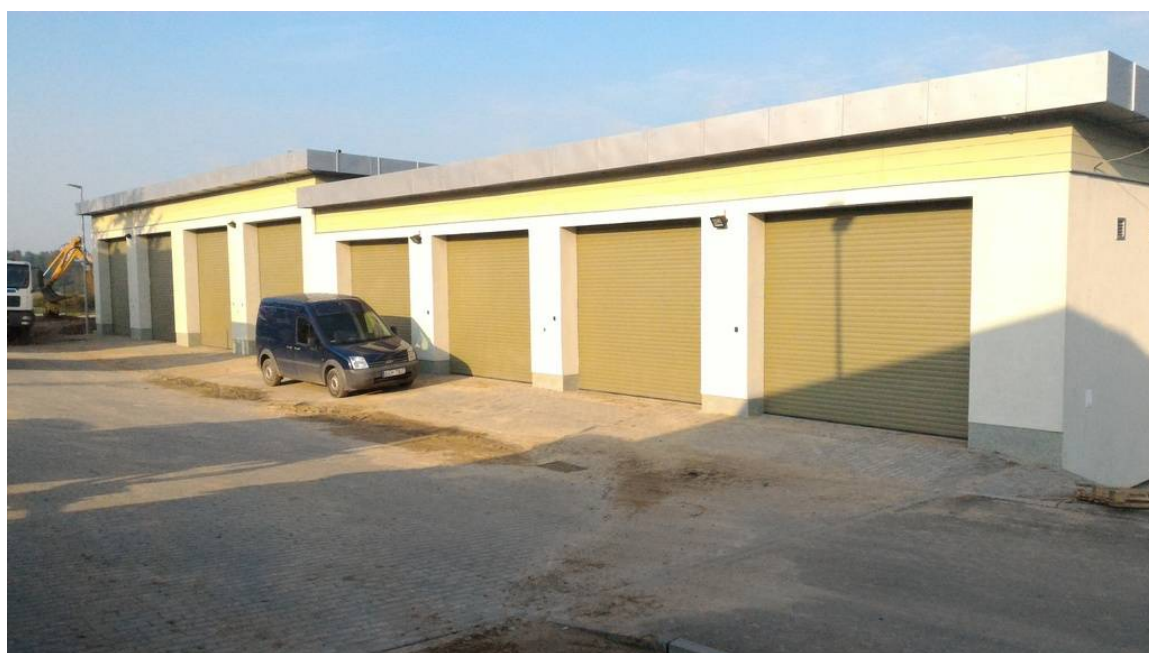
Obiekt nr 3 – garaże.
